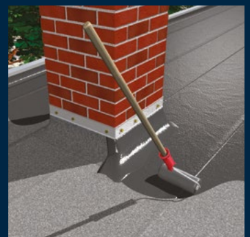
Reparatie oude Bitumen lagen
