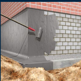
Afdichting buitenzijde Betonnen muren
