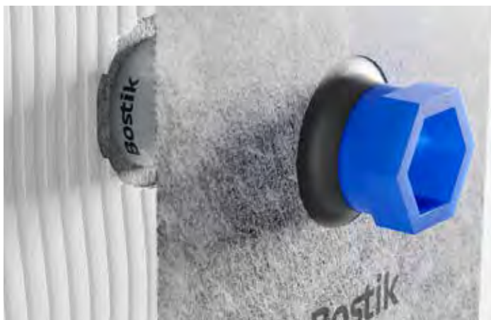
3. Manschette über SMART CLICK stülpen und in die AIV einbinden.
