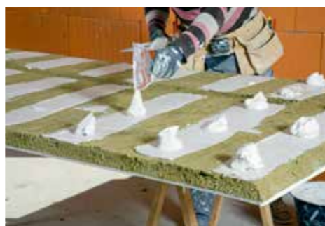
3/ POSE DES PLOTS D'ENDUIT
