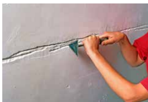
2/ CREUSER LA FISSURE
