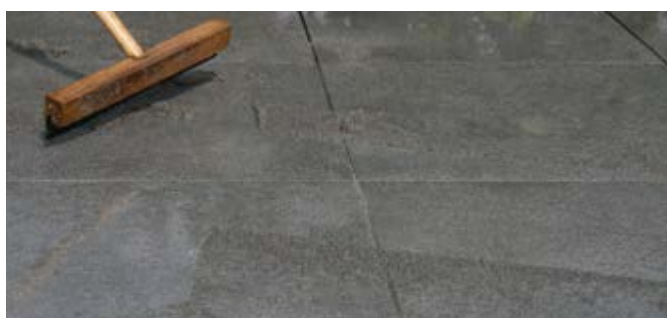
7. BESTRATING INVOEGEN MET BOSTIK HOVENIERS VOEGMORTEL 1C FLEX
