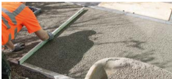
3. AANBRENGEN VAN DE DRAINAGEMORTEL EN AFREIEN TOT EEN LAAG DIKTE VAN 4 CM
