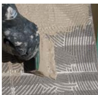
5. AANBRENGEN VAN DE LIJM OP DE ONDERKANT VAN DE TEGEL
