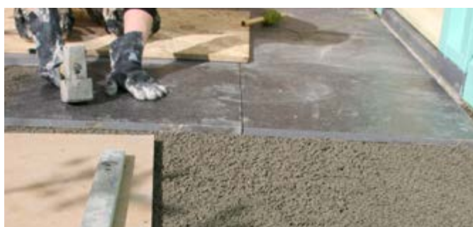
6. INKLOPPEN VAN DE TEGEL IN DE DRAINAGEMORTEL
