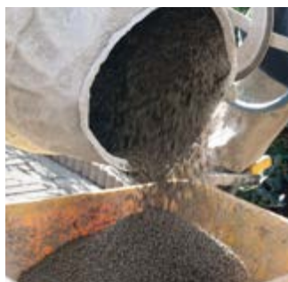
2. MIXEN BINDMIDDEL EN SPLIT IN DE BETONMOLEN
