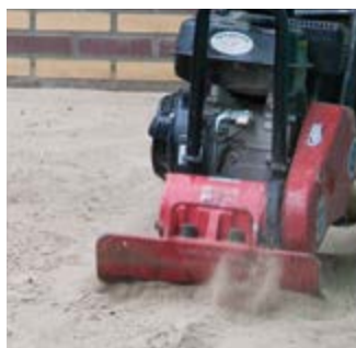
1. VERDICHTEN VAN HET ZANDBED
