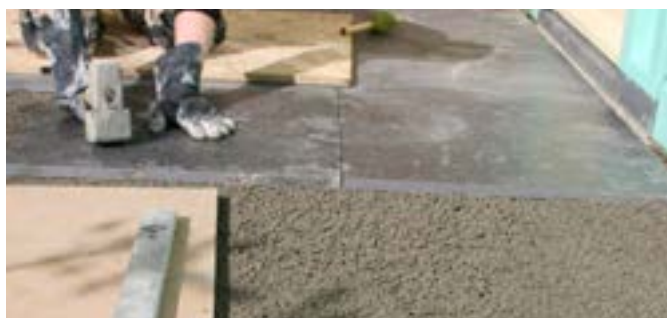
6. INKLOPPEN VAN DE TEGEL IN DE DRAINAGEMORTEL
