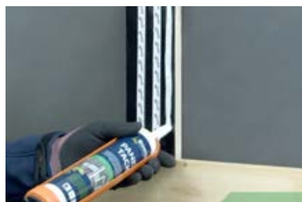
AANBRENGEN LIJM
