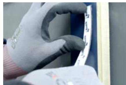
FOAMTAPE AANBRENGEN
