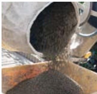
2. GÂCHAGE DU LIANT ET GRAVIER DANS LA BÉTONNIÈRE
