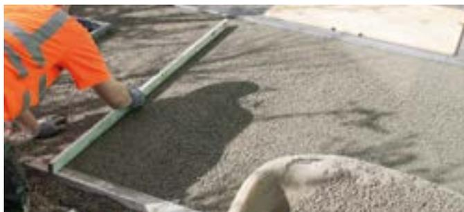
3. APPLICATION DU MORTIER DE DRAINAGE ET DRESSAGE JUSQU'À UNE COUCHE D'ÉPAISSEUR DE 4 CM
