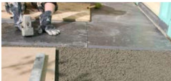
6. FIXATION DE LA DALLE DANS LE MORTIER DE DRAINAGE
