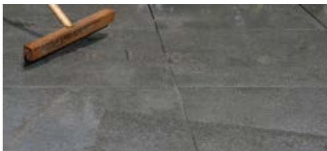
7. JOINTOYER LE PAVAGE AVEC MORTIER DE JOINTOIEMENT 1C FLEX
