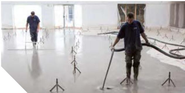
Convient à tous types de supports et domaines d'emploi (privatif ou tertiaire). Utilisation en intérieur. Classement U4 P3 E3 C2. Chape prête a recevoir tous types de revêtements sans enduit de sol. Ne peut être considérée comme chape d'usure et doit être revêtue. La mise en œuvre doit se faire dans des locaux hors d'air & hors d'eau.
