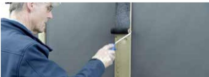
El primario SX Black está diseñado para ser usado con superficies de madera porosa y no deberá ser usado sobre madera barnizada. Para madera barnizada o pintada deberán consultarlo con Bostik. Cuando peguen sobre soportes metálicos, deberá aplicarse el primario limpiador Prep M o e primario Panel Tack.
