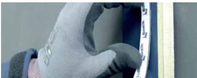
Se deberán colocar dos tiras de cinta espumada en los perfiles de aluminio tipo "T", dejándolas justo detrás de donde quedará el borde de los paneles. La cinta deberá colocarse justo en el borde de los paneles a fin de evitar el riesgo de que el adhesivo sea presionado y expulsado fuera del borde del panel invadiendo la parte de la junta entre panel y panel. Se deberán dejar 20 mm de espacio disponible a un lado de cada una de las tiras de cinta espumada a fin de poder colocar el adhesivo.
