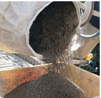
2. MIXEN BINDMIDDEL EN SPLIT IN DE BETONMOLEN
