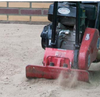
1. VERDICHTEN VAN HET ZANDBED
