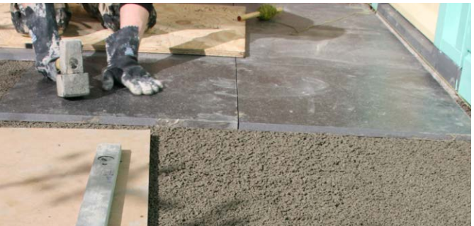
6. INKLOPPEN VAN DE TEGEL IN DE DRAINAGEMORTEL
