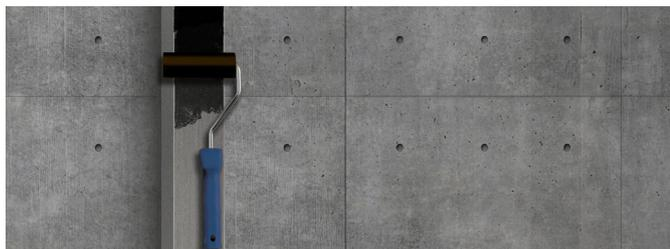
Agitez la boîte fermée de Prep G Plus avant l'utilisation et versez la quantité de primaire dans un bac à peinture propre. Utilisez l'ensemble d'application spécial avec les rouleaux. Appliquez suffisamment de primaire sur la surface de collage en une couche ou un film épais et homogène. Après application, laissez
