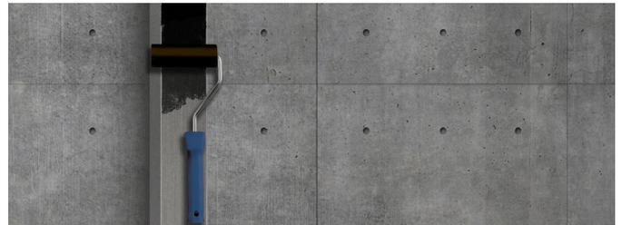
Agitez la boîte fermée de Prep G Plus avant l'utilisation et versez la quantité de primaire dans un bac à peinture propre. Utilisez l'ensemble d'application spécial avec les rouleaux. Appliquez suffisamment de primaire sur la surface de collage en une couche ou un film épais et homogène. Après application, laissez sécher au minimum 30 minutes. Les surfaces traitées doivent être utilisées dans les 24 heures.
