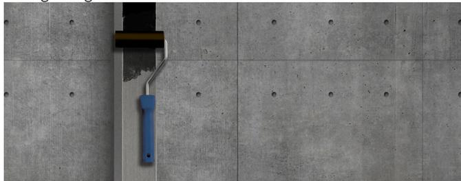
Agitez la boîte fermée de Prep G Plus avant l'utilisation et versez la quantité de primaire dans un bac à peinture propre. Utilisez l'ensemble d'application spécial avec les rouleaux. Appliquez suffisamment de primaire sur la surface de collage en une couche ou un film épais et homogène. Après application, laissez sécher au minimum 30 minutes. Les surfaces traitées doivent être utilisées dans les 24 heures.
