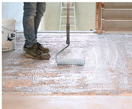
Projet: Wageningen University & Research (NL). 7 500 m 2 de support à réparer, à égaliser et à finir avec un revêtement de sol en PVC à coller
