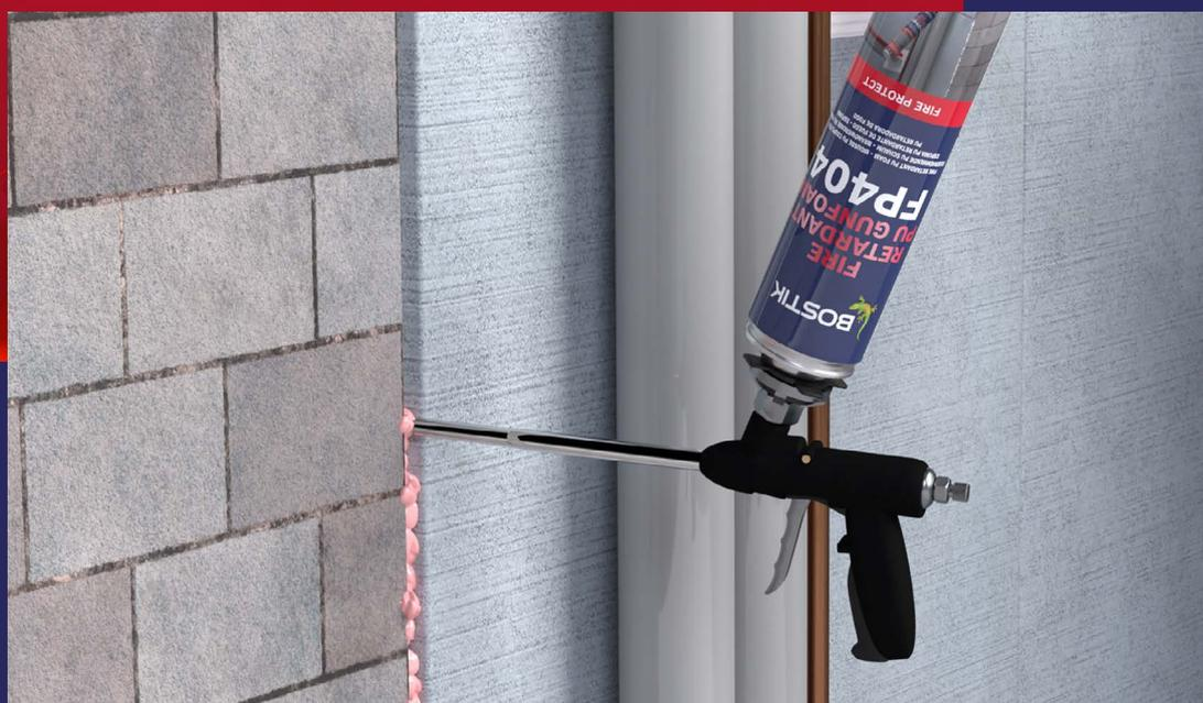
Après la construction des barrières coupe-feu et pare-fumée, il convient d'accorder une attention particulière aux joints linéaires et aux traversées. En effet, ce n'est que s'ils sont dotés de joints anti-incendie et anti-fumée adéquats que la propagation des flammes, de la fumée et des émanations toxiques peut être efficacement contrôlée et limitée.
