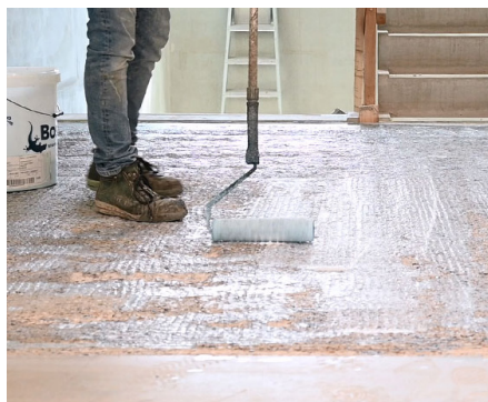
Project: Wageningen University & Research, Wageningen. 7.500 m 2 ondervloer repareren, egaliseren en vervolgens afwerken met te verlijmen PVC-vloer.
