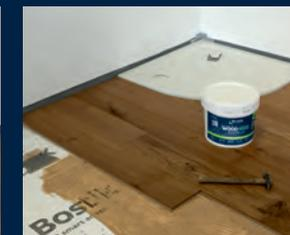
4 Nach mindestens 24 Stunden Trocknung der geklebten Abdichtbahn wird das geeignete Parkett mit WOOD H550 ECO PLUS verklebt. Die Randfugen werden später mit einem geeigneten Hybrid-Dichtstoff, z.B. PK PROFI SEAL SMP verfügt.
