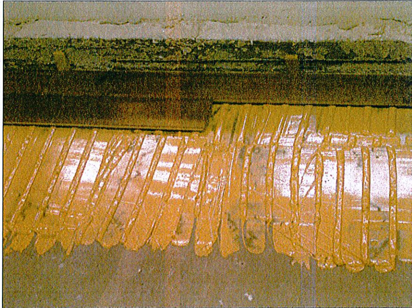
Pose du parquet sur la colle
